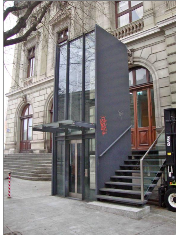
Erschließung des denkmalgeschützten Grand Théâtre in Genf über einen Außenaufzug am Seiteneingang (CH). Abb. 31 und 32
