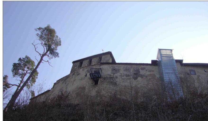
Erschließung der Burg Hohenklingen, Stein am Rhein, durch Anbau eines Außenaufzugs aus Glas. Hierbei handelt es sich um ein Denkmalschutzobjekt. (CH). Abb. 33 und 34
