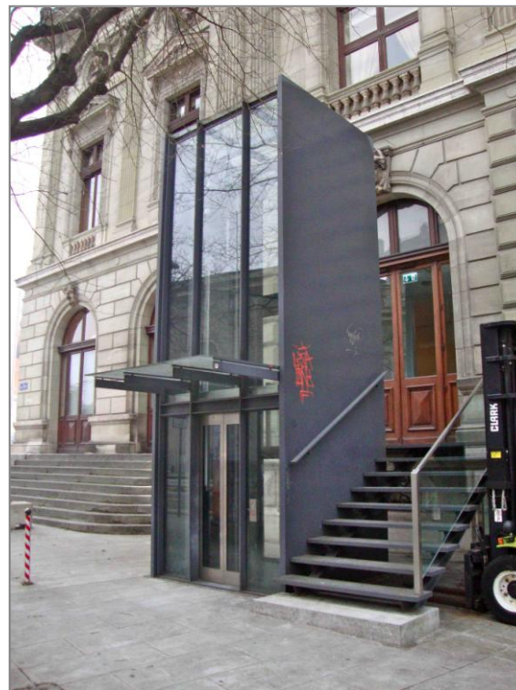
Zpřístupnění památkově chráněné budovy Grand Théâtre v Ženevě pomocí venkovního výtahu u bočního vchodu (CH). Obr. č. 31 a 32
